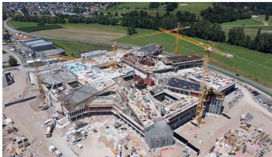
Von der Planung bis zur Realisierung eines Klinik-Neubaus ist es ein langer Weg: Planungs- sowie Baustellenansicht des neuen Zentralklinikums in Lörrach
