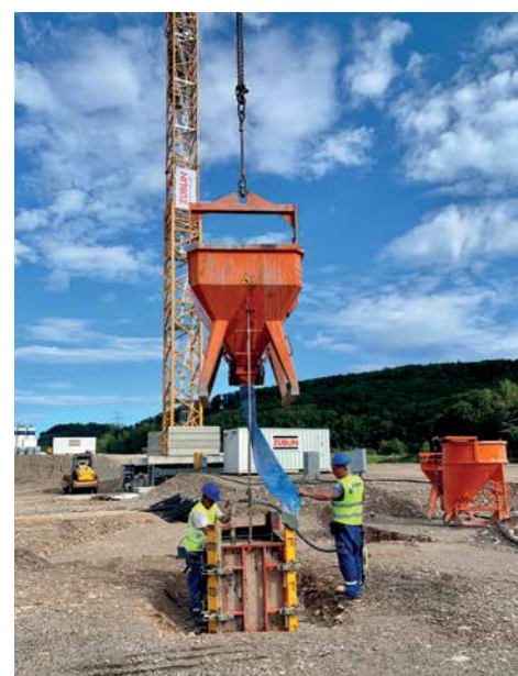
Nach eingehender Planung ist es endlich soweit: Der Grundstein des neuen Zentralklinikums Lörrach wird gegossen
