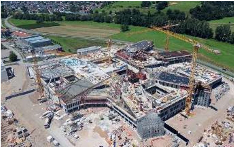
Die Sockelgeschosse sind in einem Raster von 7,50 Meter mal 7,50 Meter konzipiert. Das ermöglicht eine problemlose Umnutzung der Räumlichkeiten.
